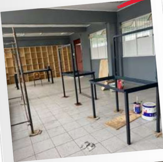
Liceo Juan Dante Parraguez Sala de Climatización y Refrigeración
